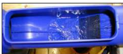
Reiniging van de filter na de wisselsprong
